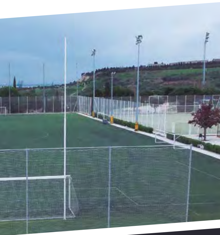
Instalación redes protección / nets protection facility by Esteban. INEFC, Barcelona
